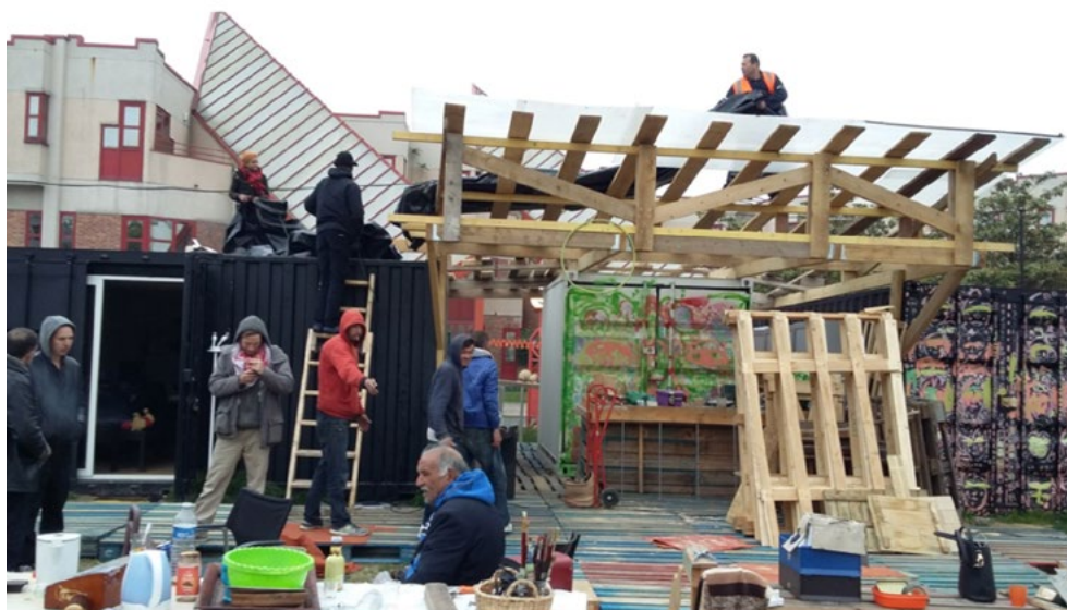
Le Kiosque solidaire en plein chantier.
